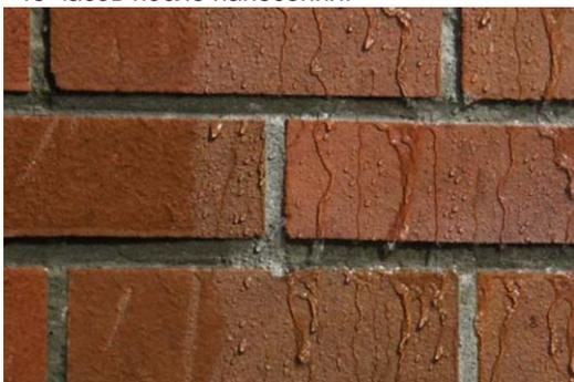
Пример гидрофобной обработки конкурентным продуктом. Меньшее время защиты, стена при этом не дышит.
